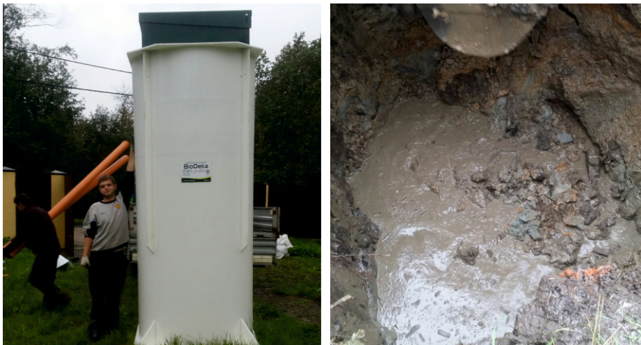
На фото «БиоДека-8 П-1800» и плывун, в который мы ее установили.
