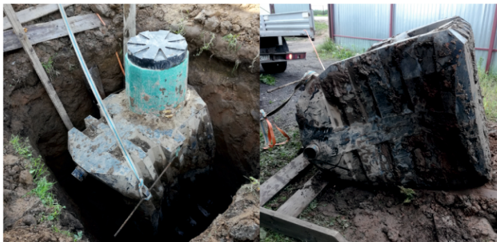
На фото «Термит Профи 2.0» в процессе демонтажа.
