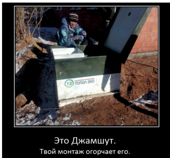
Недозакопанная на полметра станция «Топас».
